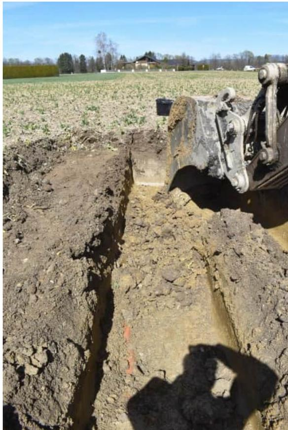
Abbildung 5: Schurf S06: Drainageleitung Bestand in ca. 0,8 m Tiefe unter Geländeoberkante. Aufnahmedatum 04.04.2023.
